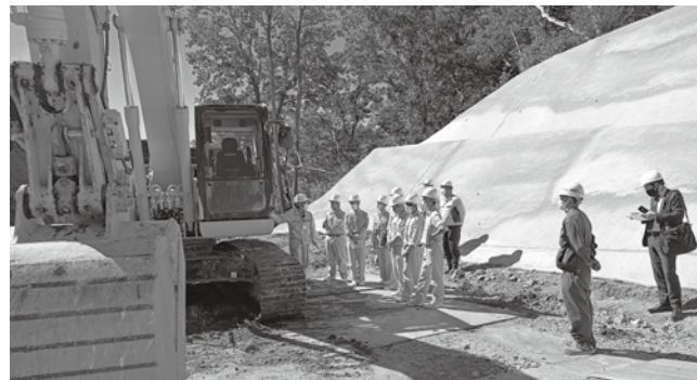
▲ICT建設機械の説明を受ける生徒
