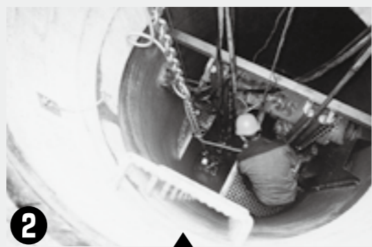
2 調査するとマンホールに設置しているポンプが止まっていたので、引き上げて修理します。
