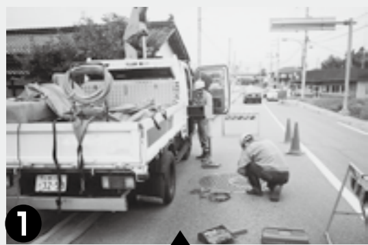
1 ポンプの異常を検知したマンホールへ向かいます。
