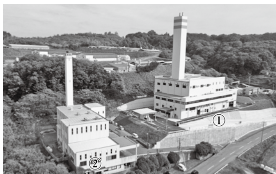
①完成した新焼却施設 ②旧施設
