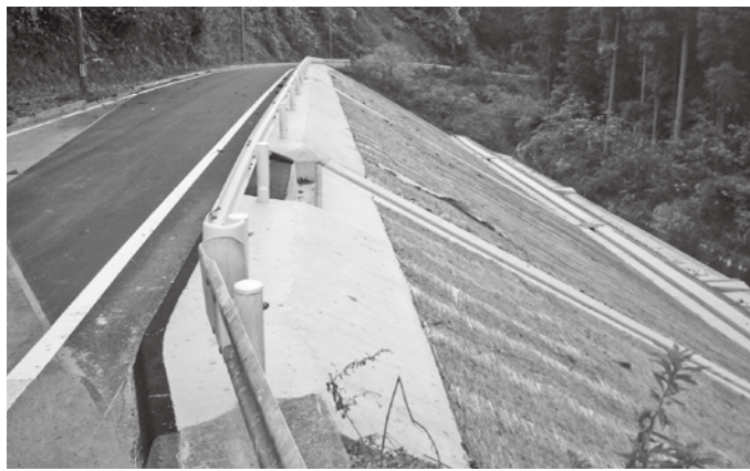
災害復旧事業による復旧後の状況
