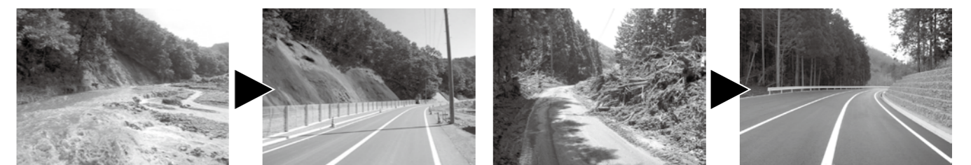
落石対策工事
