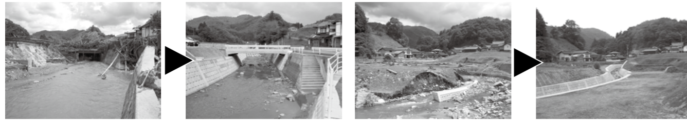
断面を阻害していた橋の架け替え
