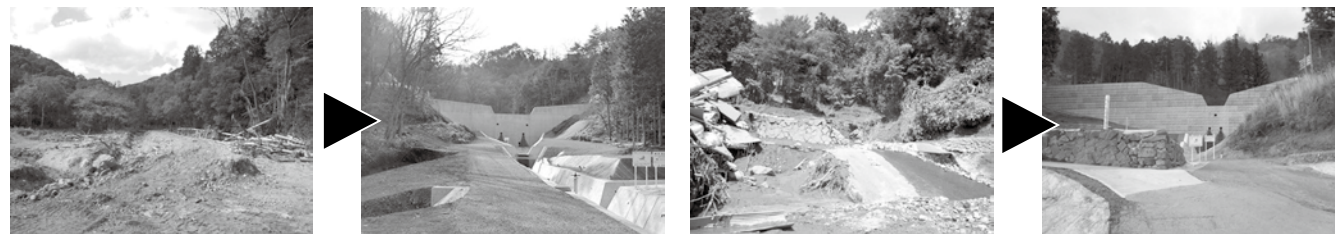
砂防えん堤の整備(先大戸川左支川)
