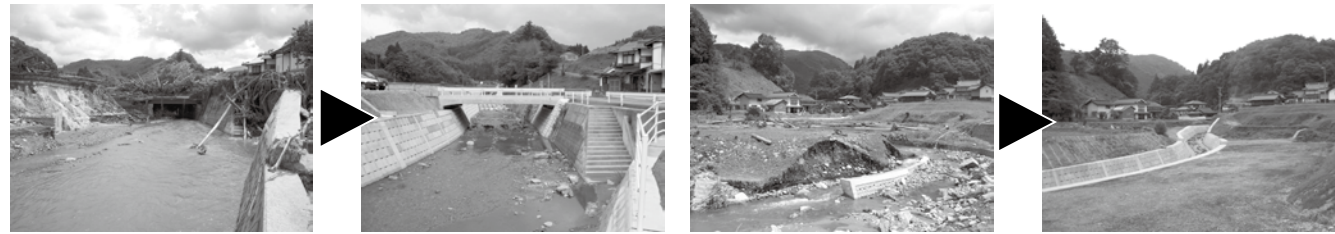
断面を阻害していた橋の架け替え
