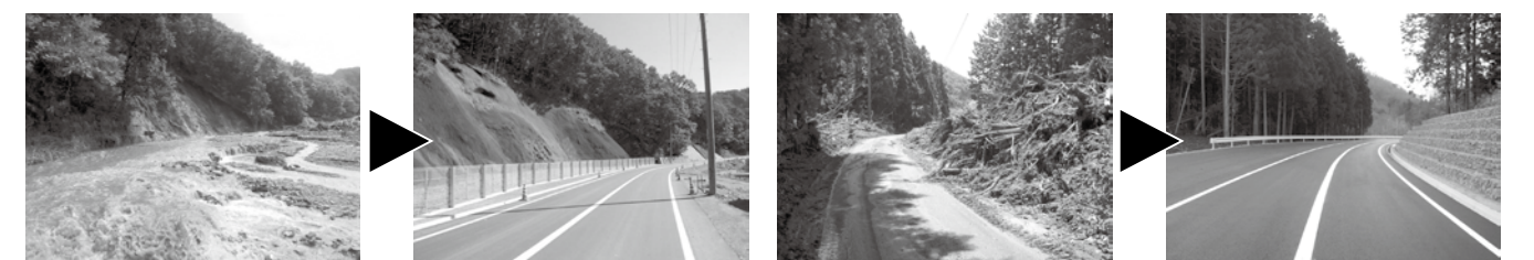
落石対策工事
