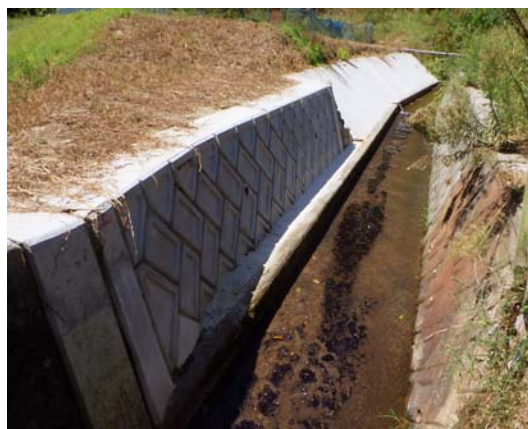
水路災害復旧の一部 (庄原市川西町)
