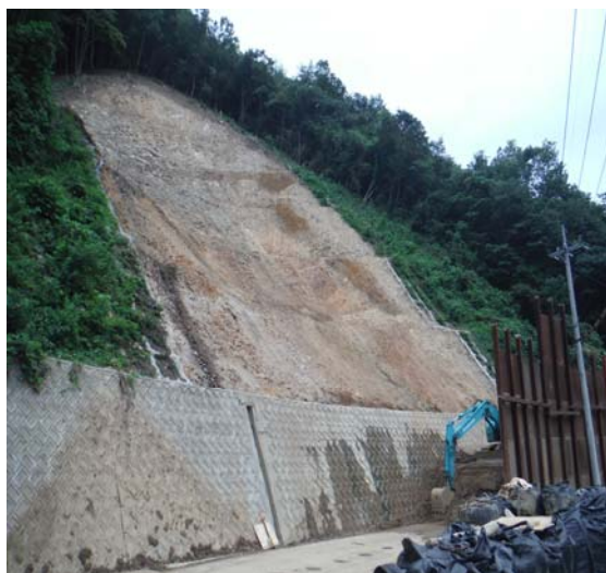
市道横畠高茂線 復旧工事進む (庄原市水越町)
