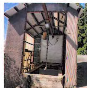
浸水のための設備
