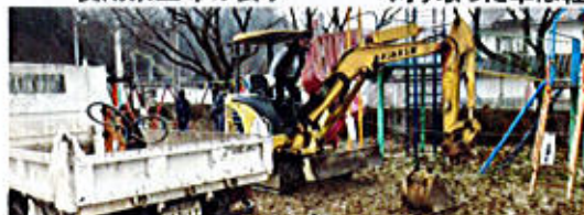
遊具の撤去工事
