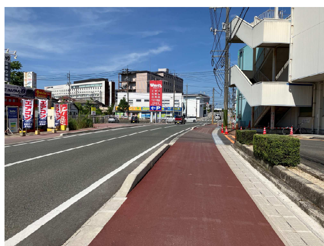
▲高質空間形成施設/ 市道本町三日市線整備
