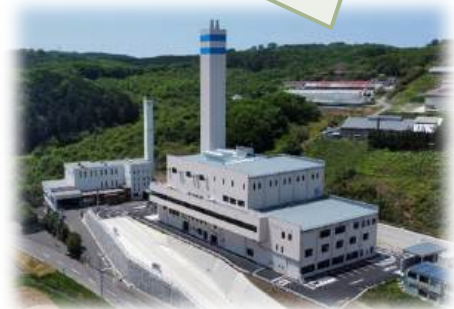
備北クリーンセンター
