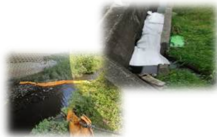
河川や農業用水路の油等による水質汚濁防止対策（オイル付着マット（右上）及びオイルフェンス（左下）の敷設）
