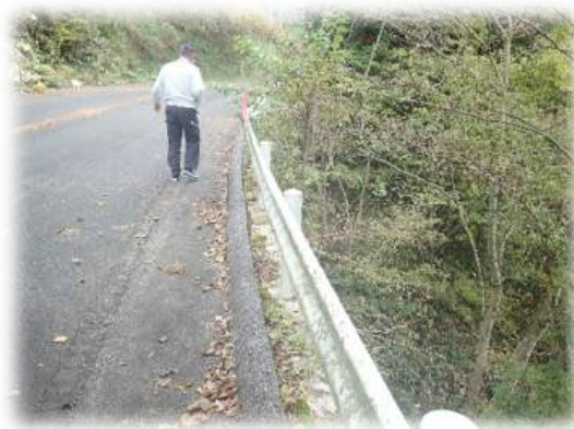
不法投棄監視パトロールの様子
