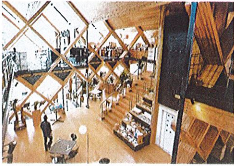
銘建工業(株)本社 CTL材で建築された事務所
