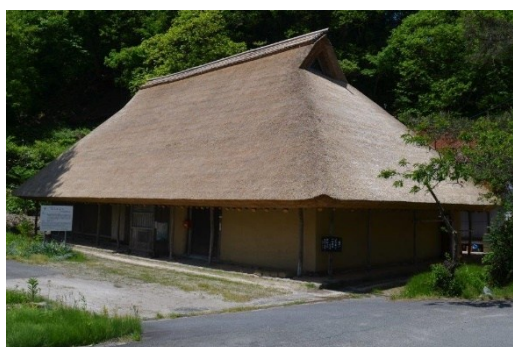
↑ (国指定重要文化財「堀江家住宅」／ 保存修理工事（屋根葺き替え等）完成)
