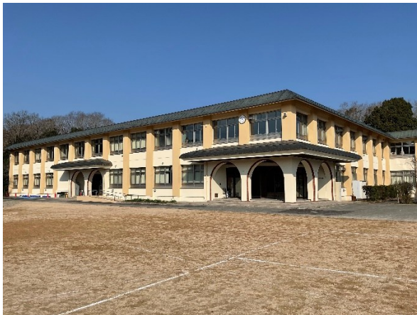
（改修した小学校の校舎）
