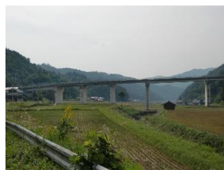
元常大橋 L=176.0m(PC橋) 1992年架設 跨道橋
