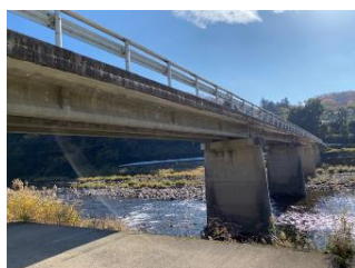
高茂橋 L=100.0m(PC橋) 1966年架設
