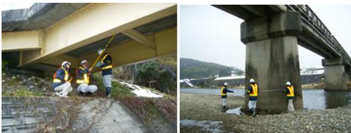
橋梁定期点検状況
