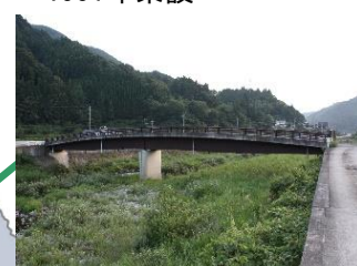
夢乃橋 L=56.0m(鋼橋) 1997年架設
