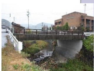
泉橋 L=15.3m(PC橋) 1986年架設
