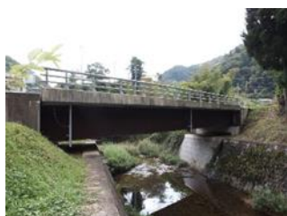
新濁田橋 L=25.8m(鋼橋) 2000年架設
