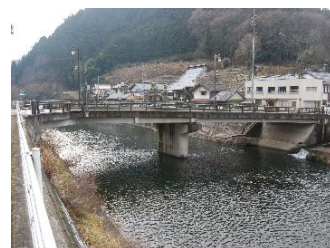
大橋 L=43.8m(PC橋) 1991年架設
