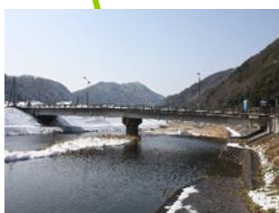
川平橋 L=63.7m(PC橋) 1993年架設
