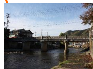
大橋 L=42.5m(RC橋) 1966年架設
