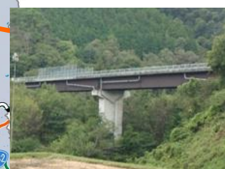
加谷大橋 L=134.2m(鋼橋) 1993年架設 跨線橋
