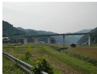
元常大橋 L=176.0m(PC橋) 1992年架設 跨道橋
