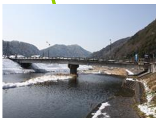
川平橋 L=63.7m(PC橋) 1993年架設
