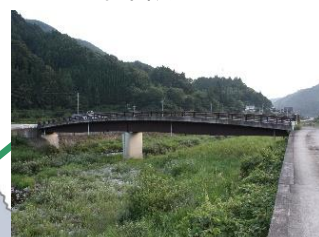
夢乃橋 L=56.0m(鋼橋) 1997年架設
