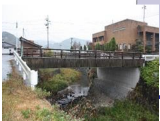
泉橋 L=15.3m(PC橋) 1986年架設
