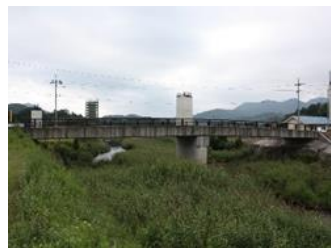
岡大内橋 L=43.8m(PC橋) 2001年架設
