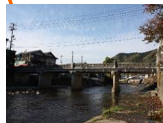
大橋 L=42.5m(RC橋) 1966年架設
