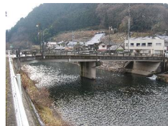
大橋 L=43.8m(PC橋) 1991年架設
