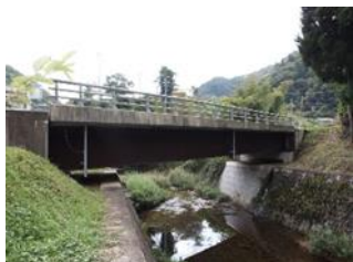
新濁田橋 L=25.8m(鋼橋) 2000年架設
