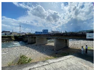
車橋 L=66.0m(RC橋) 1959年架設
