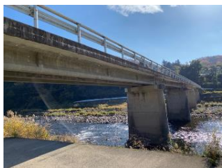
高茂橋 L=100.0m(PC橋) 1966年架設
