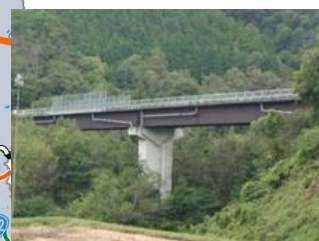
加谷大橋 L=134.2m(鋼橋) 1993年架設 跨線橋
