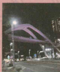
千葉都市モノレール セントラル アーチ
