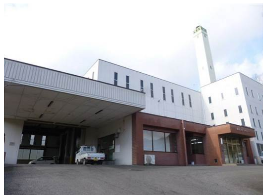
備北クリーンセンター
