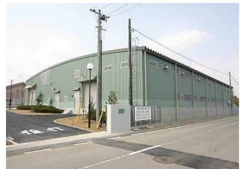
庄原市一般廃棄物最終処分場 (グリーンハウス)
