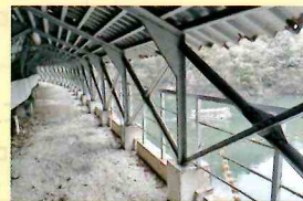
ダムに向かう岩壁回廊
