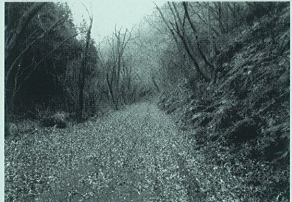
令和4年度に実施した森林作業道の補修
