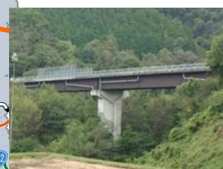
加谷大橋 L=134.2m(鋼橋) 1993年架設 跨線橋
