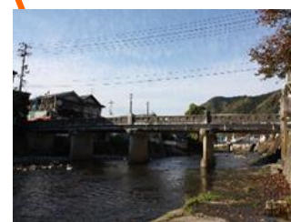
大橋 L=42.5m(RC橋) 1966年架設
