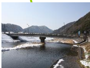
川平橋 L=63.7m(PC橋) 1993年架設
