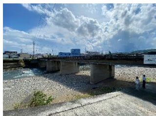
車橋 L=66.0m(RC橋) 1959年架設
