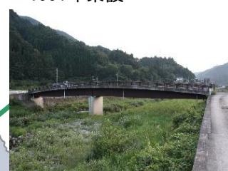
夢乃橋 L=56.0m(鋼橋) 1997年架設
