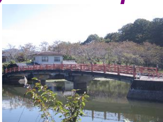
弁天橋 L=40.0m(PC橋) 1979年架設
