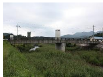
岡大内橋 L=43.8m(PC橋) 2001年架設
