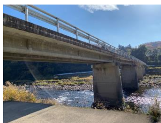
高茂橋 L=100.0m(PC橋) 1966年架設
