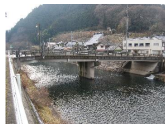
大橋 L=43.8m(PC橋) 1991年架設
