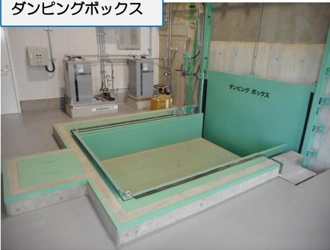
● 今までの焼却施設では、持ち込んだ燃えるごみを、直接「ごみピット（燃えるごみを貯めておく場所）」へ投入して頂いていましたが、新焼却施設では、安全に投入できるようにダンピングボックスに入れて頂きます。
