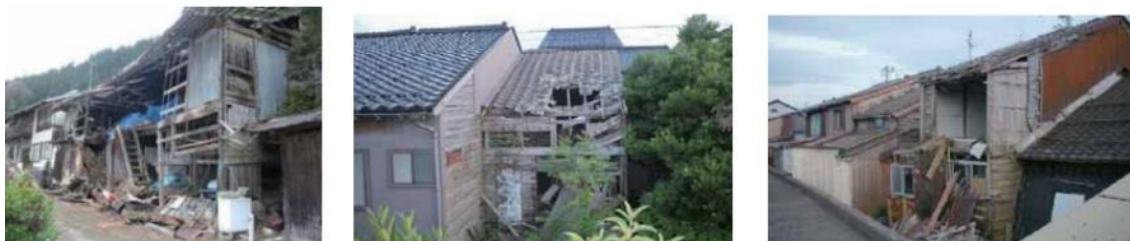
図 倒壊している空き家の例
