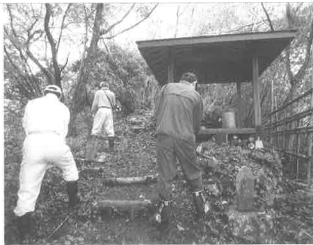
遊歩道の整備
