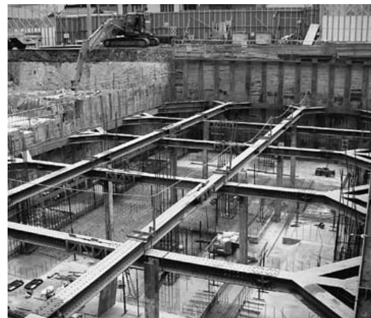
機械室部分の地下工事
