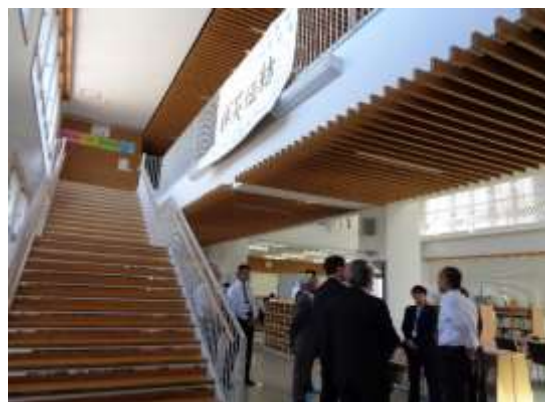
階段の高さも小学生仕様に設計されている。
