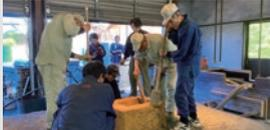
土を練り、炉を築きます。築炉後、薪を燃やし炉を乾燥させます。
