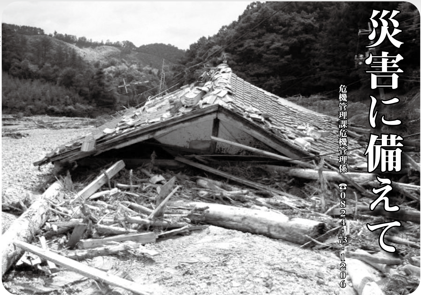
▶平成22年7月の豪雨で被災した家屋
