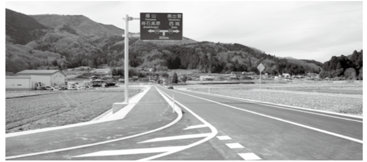
2車線に改良された一般県道下千鳥小奴可停車場線
