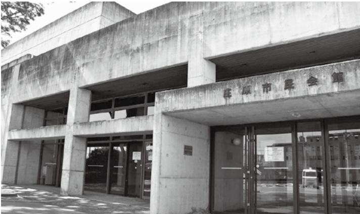
大規模改修工事に着手する庄原市民会館
