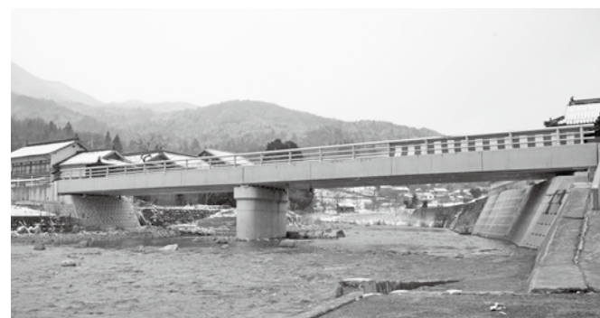
完成した市場橋
