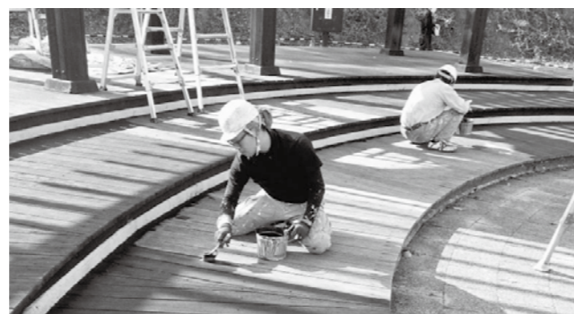
▲ステージの塗り替え作業を行う塗装業者職員
