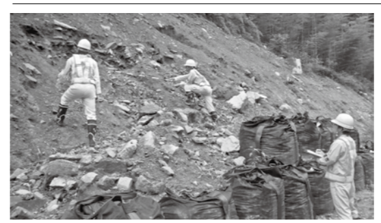
市道法面の点検の様子
