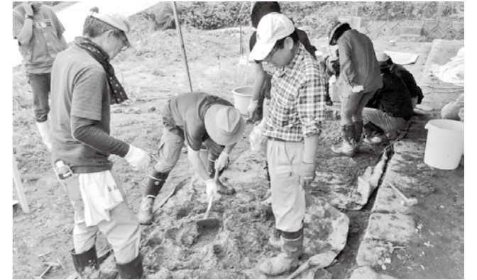
▲壊れた土壁を崩して、新たに練り直す参加者
