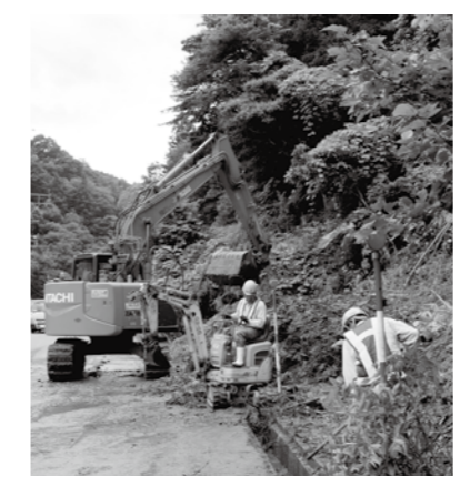
災害復旧工事の様子
