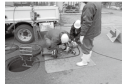
ポンプに物が詰まると、ポンプを引き上げて分解し、修理します
