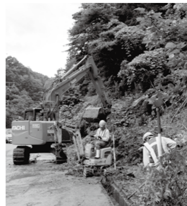
災害復旧工事の様子
