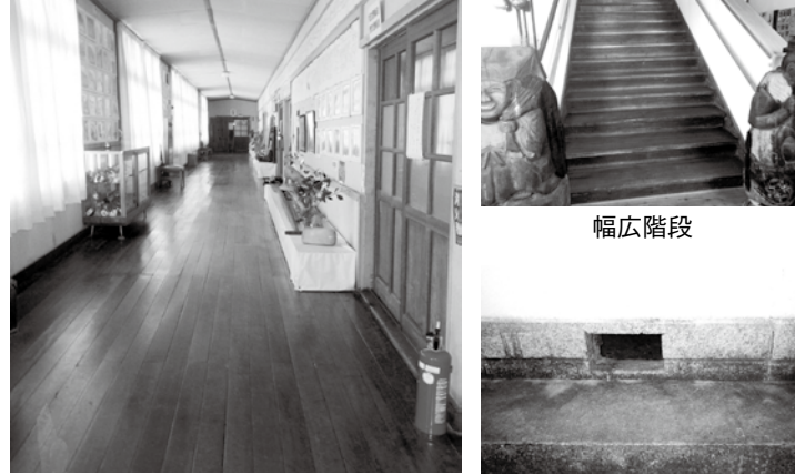
2階の廊下など、拭き掃除で光沢がある 基礎石は、花崗岩を加工したもの
