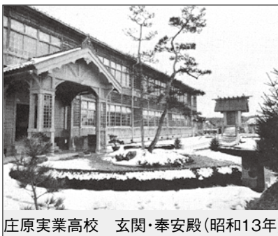
庄原実業高校 玄関・奉安殿(昭和13年)
