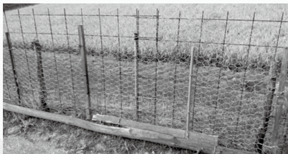
メッシュを曲げられ縦横に補強。稲刈り前、毎日点検メンテナンスされた模範柵です（市町Sさん）。
