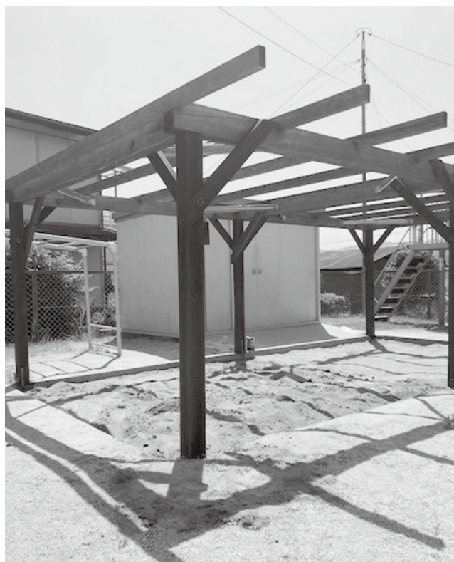
▲修繕と塗装された日よけ棚
