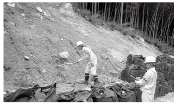
のり面の点検の様子
