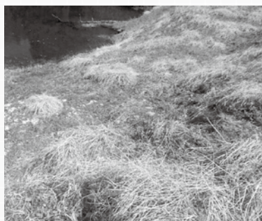
水源のため池。ワラビなどの餌を求めてイノシシが堤体を掘っていた。
