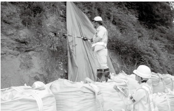
のり面の点検の様子
