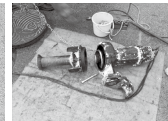
ポンプに物が詰まると、ポンプを引き上げて分解し、修理します
