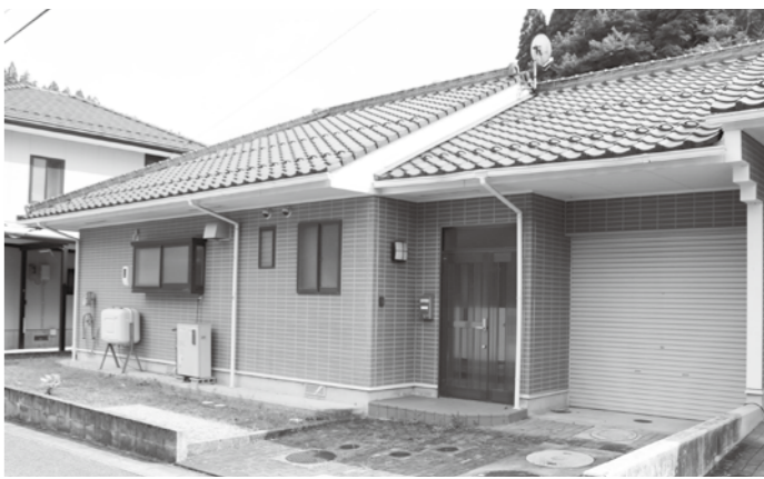
西城町に整備された高齢者冬期安心住宅
