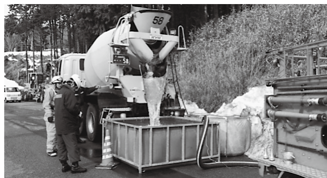
▲ミキサー車による簡易水槽への補給（本村町・蘇羅比古神社周辺）
