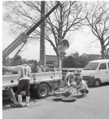
ポンプを引き上げて修理
