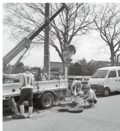
ポンプを引き上げて修理
