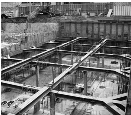
機械室部分の地下工事
