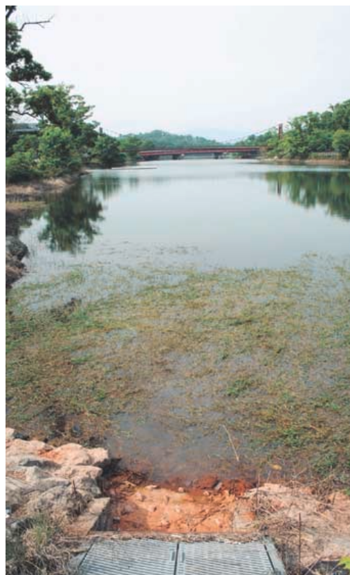
本村川から水を引く国兼池。 手前が導水路の終点。
