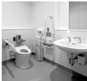
新しい多目的トイレ
