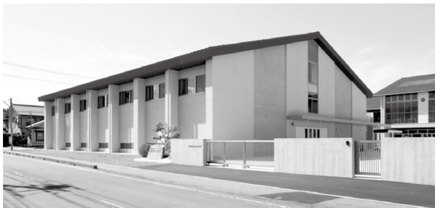
新屋内運動場の外観
