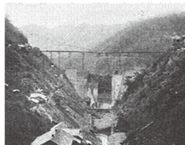
▲高暮ダム建設当時の様子
