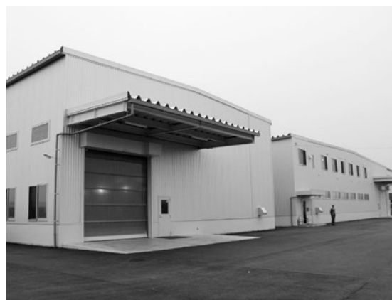
完成した新工場。手前が塗装工場、奥が組立工場
